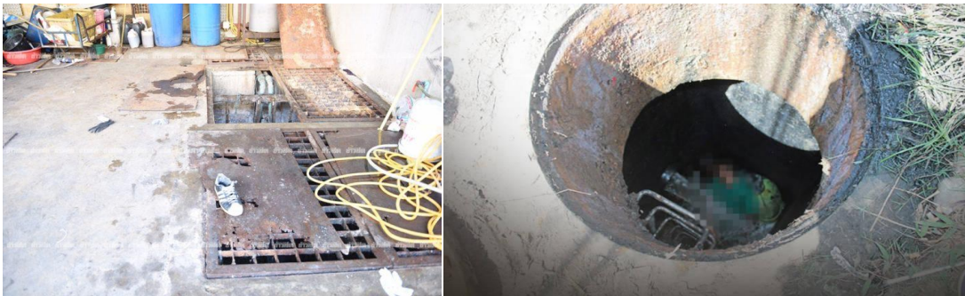
รูปที่ ๒ ช่องเปิด ทางเข้า ทางออก ที่อับอากาศ
