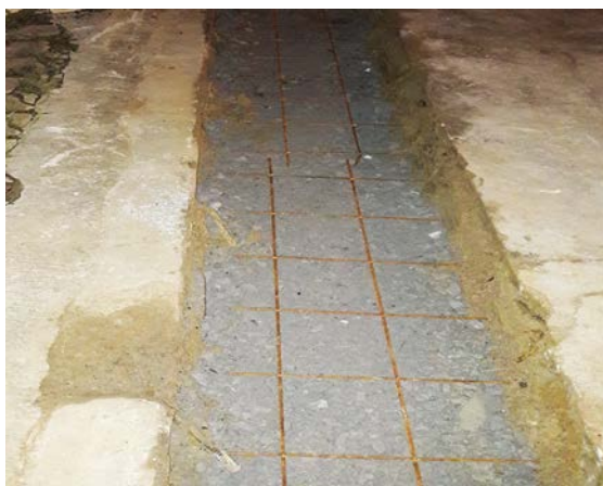
รูปที่ ๓ แสดงการวางเหล็กไวเมทบริเวณก้นบ่อ
