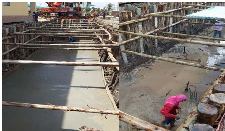
รูปที่ ๑๑ แสดงการป้องกันดินพังทลายโดยใช้ไม้
