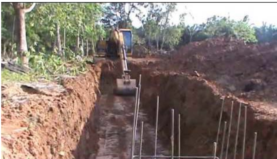
รูปที่ ๒ แสดงการขุดบ่อโดยใช้รถแบ็คโฮ
