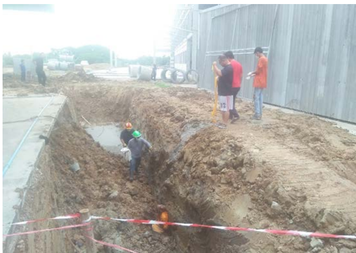
รูปที่ ๑ แสดงอุบัติเหตุดินพังทลายทับร่างลูกจ้าง
