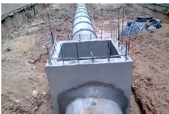
รูปที่ ๖ แสดงการประสานเชื่อมต่อโดยใช้คอนกรีต
