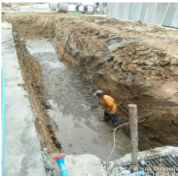
รูปที่ ๔ แสดงการเทและเกลี่ยคอนกรีตผสมเสร็จเพื่อใช้ทำพื้นวางท่อ
