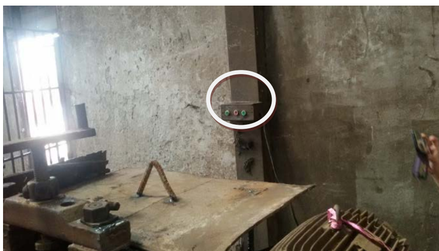
รูปภาพแสดงเครื่องรีดยัดเหล็กไม่มีปุ่มหยุดเครื่องจักรในกรณีเกิดเหตุฉุกเฉิน
