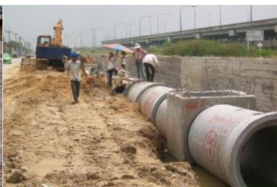
รูปที่ ๖ แสดงการประสานเชื่อมต่อโดยใช้คอนกรีต
