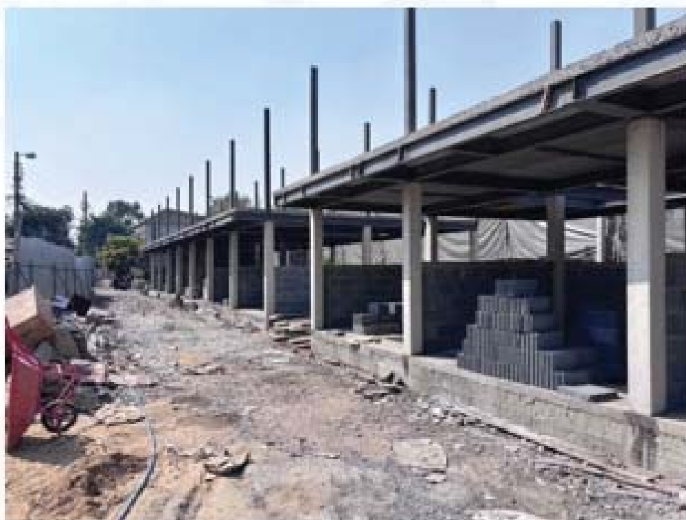
ภาพที่ ๒.๑.๒ สภาพแวดล้อมบริเวณโครงการก่อสร้าง
