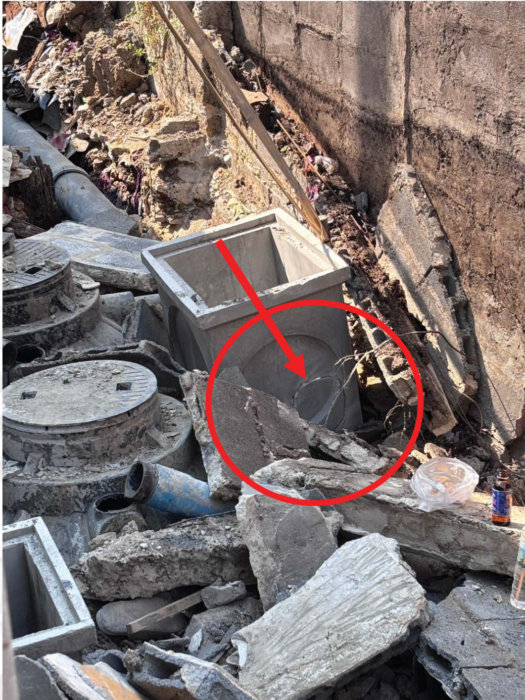
ภาพที่ ๒.๓.๓ ลูกจ้างผู้เสียชีวิตกำลังใช้ลูกหมูตัดบ่อพักน้ำเสียคอนกรีตสำเร็จรูปให้เป็นช่องวงกลม เพื่อให้สามารถนำท่อระบายน้ำคอนกรีตมาเชื่อมต่อเข้าบ่อพักน้ำเสียได้
