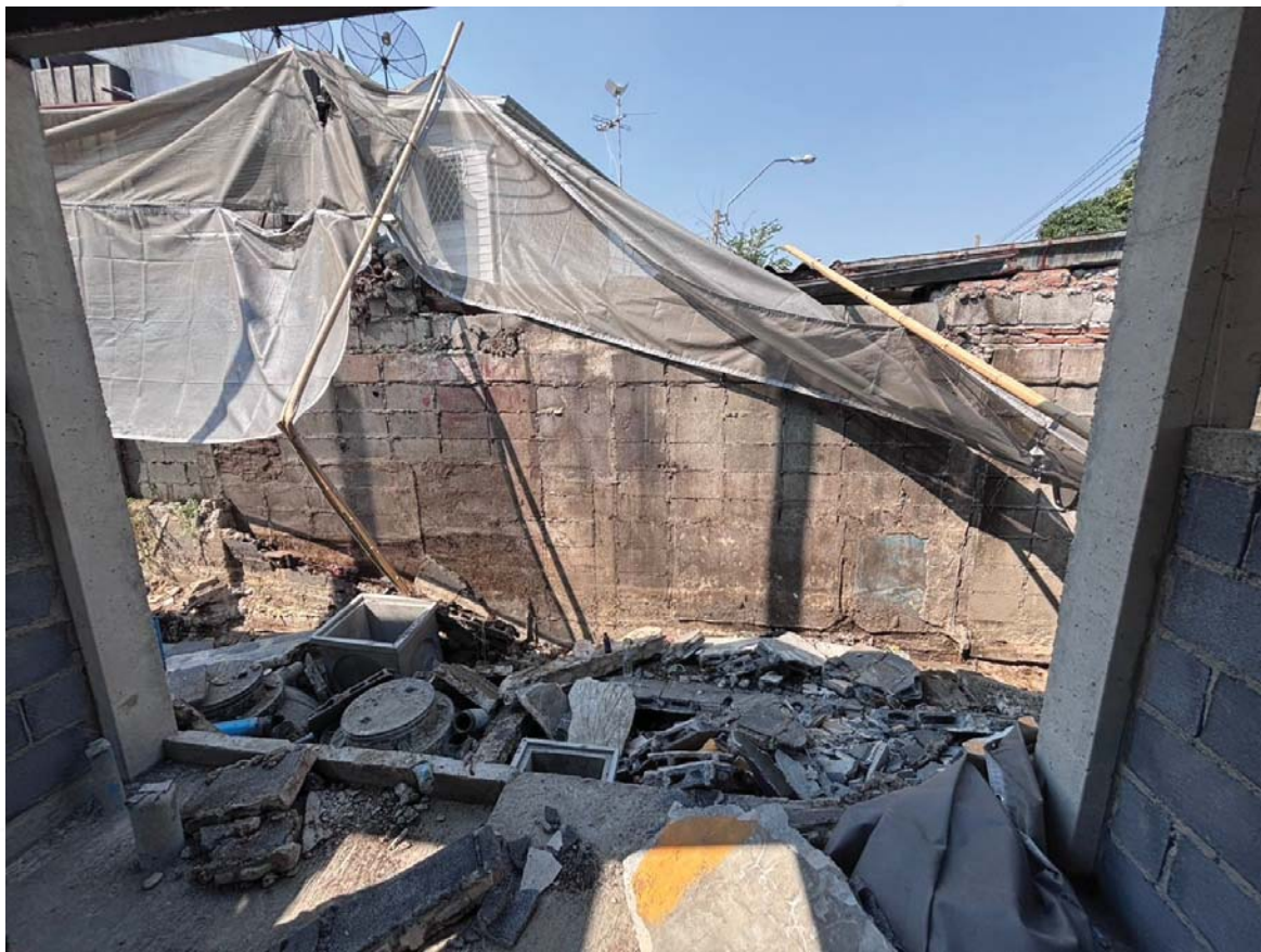
ภาพที่ ๒.๑.๒ สภาพแวดล้อมบริเวณโครงการก่อสร้าง (ต่อ)
