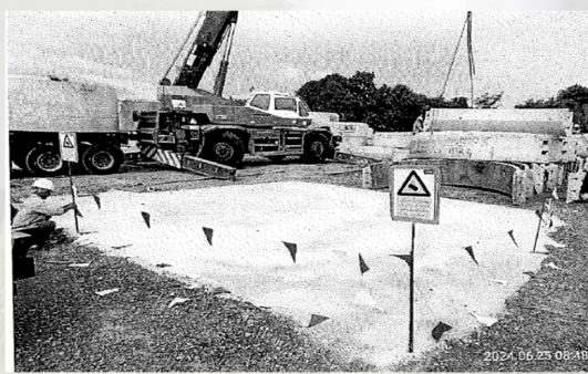
ปรับปรุงพื้นที่หลังเกิดเหตุ
