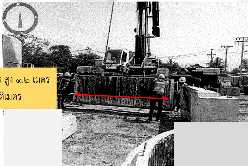
ภาพที่ ๒ ขั้นตอนการประกอบแผ่นคอนกรีต ขนาดยาว
