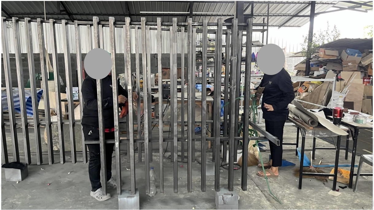
ภาพแสดงการติดตั้งราวกันตกซึ่งจะถูกเชื่อมยึดติดเป็นการชั่วคราวก่อนการพ่นสี
