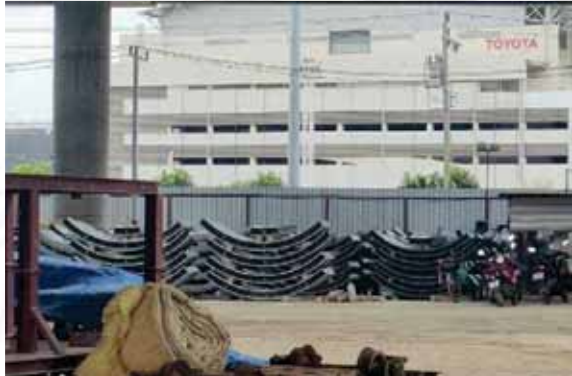
รูปที่ 10 ชั้นส่วนคอนกรีตอัดแรงสำเร็จรูป (Segment) เพื่อนำมาประกอบเป็นโครงสร้างอุโมงค์ส่งน้ำ
