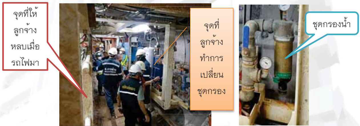
รูปที่ 1๕ พื้นที่จุดเกิดเหตุ บริเวณแบคอัพตัวที่ ๘
