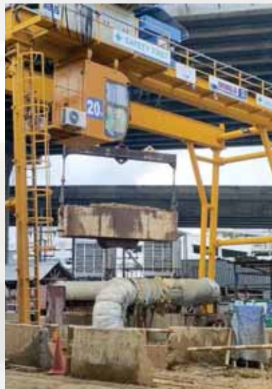
รูปที่ 12 บันจั้น เพื่อใช้ในการยก - เคลื่อนย้ายดินที่ได้จากการขุด - เจาะ
