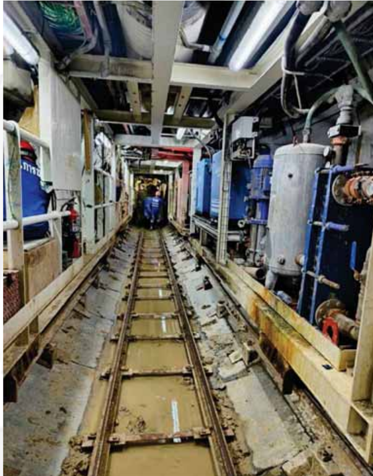
รูปที่ ๔ พื้นที่ปฏิบัติงาน ภายในอุโมงค์ซึ่งอยู่ระหว่างการก่อสร้าง
