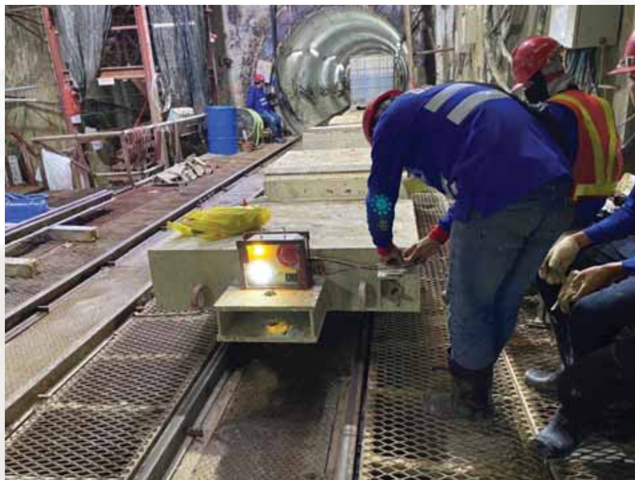
รูปที่ 1๗ พนักงานตรวจความปลอดภัย เข้าตรวจติดตามการดำเนินการปรับปรุงแก้ไข
