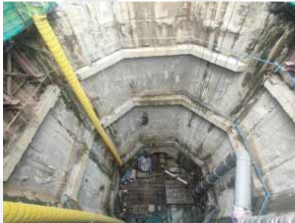
รูปที่ ๒ บ่อชาร์ป ๘ เหลี่ยม ใช้เป็นที่ขนถ่ายวัสดุและเตรียมงาน
