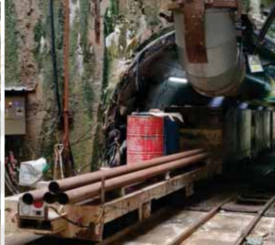
รูปที่ ๑๓ รถไฟ ใช้ในการขนส่งวัสดุและขุดดินที่ได้จากการขุด - เจาะ
