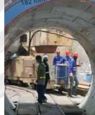
รูปที่ 10 ชั้นส่วนคอนกรีตอัดแรงสำเร็จรูป (Segment) เพื่อนำมาประกอบเป็นโครงสร้างอุโมงค์ส่งน้ำ
