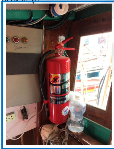
รูปภาพ : การติดตั้งถังดับเพลิงแบบเคลื่อนย้าย ขนาด ๑๕ ปอนด์ ประจำเรือ จำนวน ๓ ถัง
