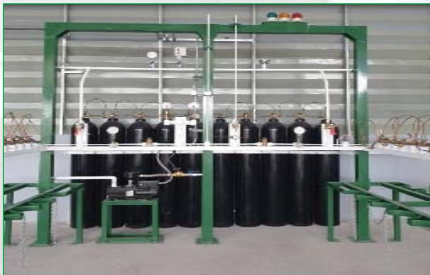
ภาพที่ ๑๕ คอกกั้นหรือโซ่กันบริเวณที่มีการจัดวางท่อ
