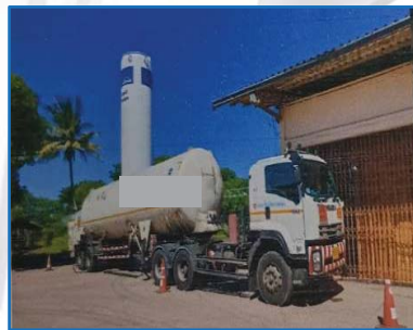
ภาพที่ ๖ - ๗ ถังเก็บออกซิเจนเหลว
