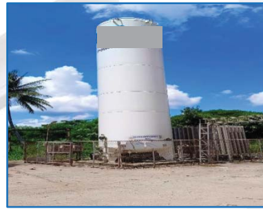
ภาพที่ ๖ - ๗ ถังเก็บออกซิเจนเหลว
