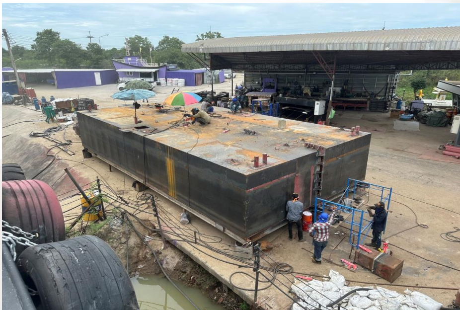
รูปที่ ๑ แสดงพื้นที่การทำงานสร้าง/ประกอบโป๊ะเหล็กลอยน้ำจำนวน ๒ โป๊ะต่อกัน
