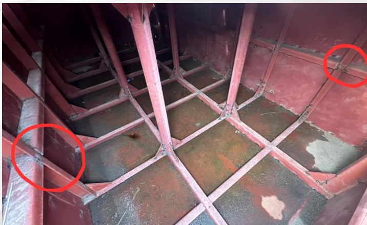
รูปที่ ๑๘ แสดงจุดที่พันสั้ฝบริเวณรอยเชื่อมภายในโປ้ะและอุปกรณ์ที่ใช้ในการทำงาน
