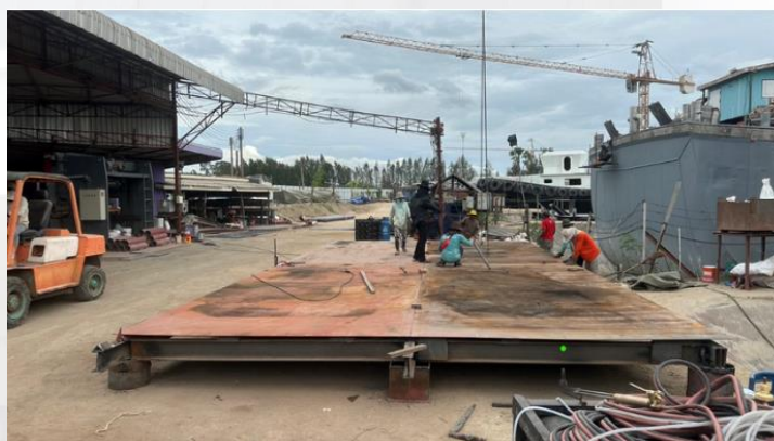
รูปที่ ๑๕ แสดงการวางเหล็กพื้นห้องของโถง
