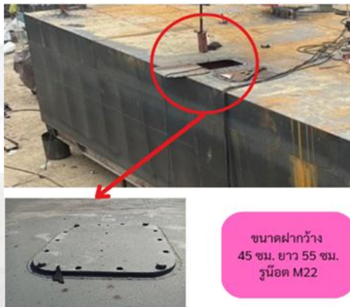
รูปที่ ๒๘ แสดงลูกจ้างพ่นสีภายในโປ้ะเสร็จแล้วปิดฝาไว้
