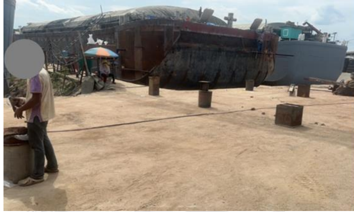
รูปที่ ๑๓ แสดงการวางเสาเหล็กสำหรับรองรับคาน
