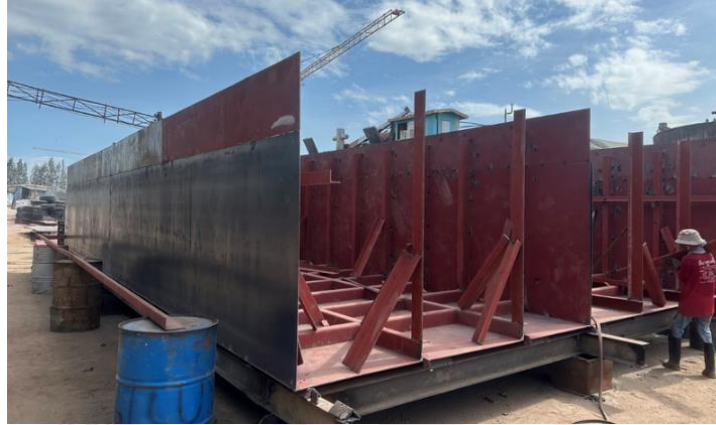
รูปที่ ๑๖ แสดงการประกอบเป็นโครงสร้างด้านข้างและด้านในโປ้ะ
