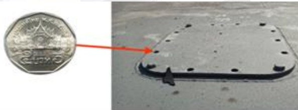
รูปที่ ๒๗ แสดงขนาดของรื้อนื้อตที่ใช้สำหรับชั้นปิดฝาทิ้งโປ้ะ
