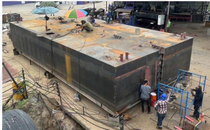
รูปที่ ๑๗ แสดงการประกอบโครงสร้างด้านบนของโປ้ะ
