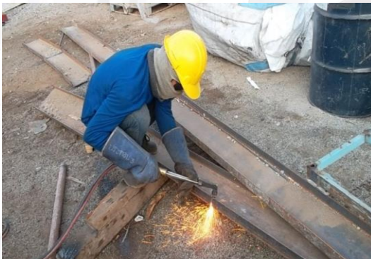
รูปที่ ๙ แสดงการตัดเหล็กด้วยเครื่องตัดด้วยก๊าซ
