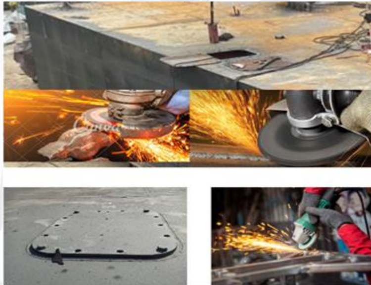
รูปที่ ๒๙ แสดงการเจียรแต่งผิวเหล็กของโປ้โดยใช้เครื่องเจียรมือซึ่งมีประกายไฟ
