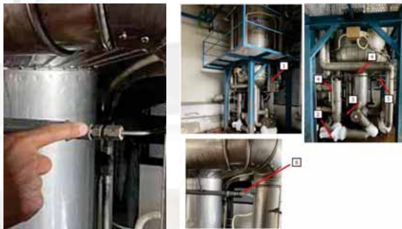
รูปที่ 5 แสดงลักษณะของข้อต่อ (แฟร์) ณ จุดเกิดเหตุ
