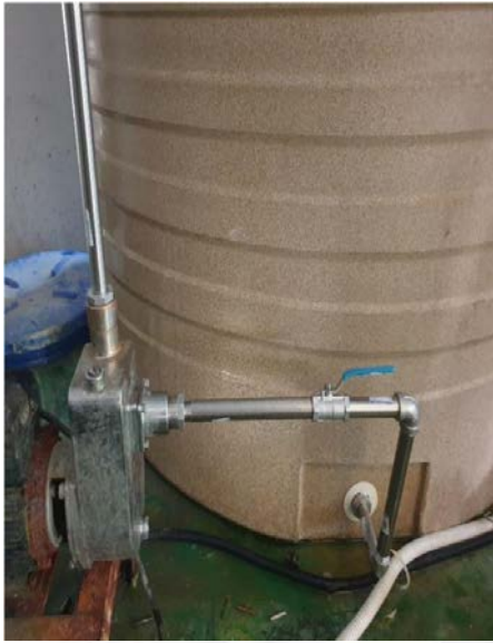
ภาพที่ ๔ การใช้ท่อและข้อต่อแบบสแตนเลส
