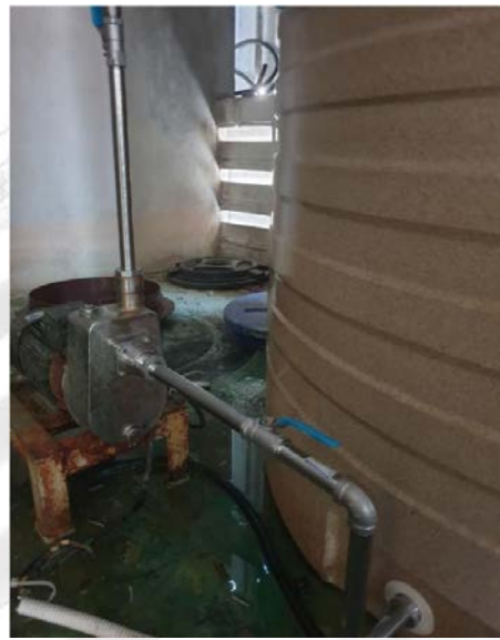
ภาพที่ ๔ การใช้ท่อและข้อต่อแบบสแตนเลส
