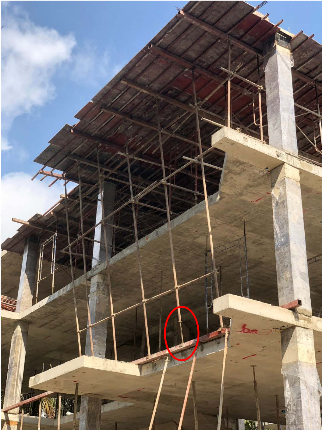
ภาพที่ ๒.๕.๒ ภาพบริเวณพื้นที่การก่อสร้าง (ต่อ)
