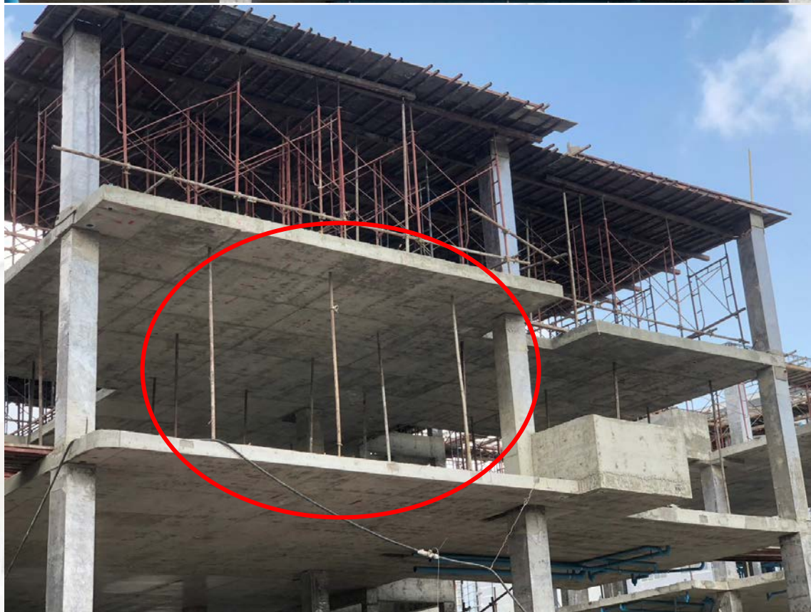
ภาพที่ ๒.๕.๒ ภาพบริเวณพื้นที่การก่อสร้าง (ต่อ)
