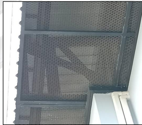
ภาพที่ ๔ ตะแกรงเหล็กฉีกที่ติดตั้งเรียบร้อยแล้ว
