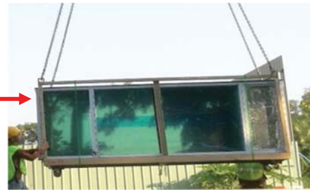
ภาพแสดงพาเลทที่ใช้ในการขนย้ายกระจกขึ้นไปติดตั้งบนอาคาร
