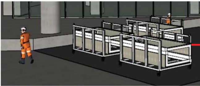
ภาพแสดงพาเลทที่ใช้ในการขนย้ายกระจกขึ้นไปติดตั้งบนอาคาร
