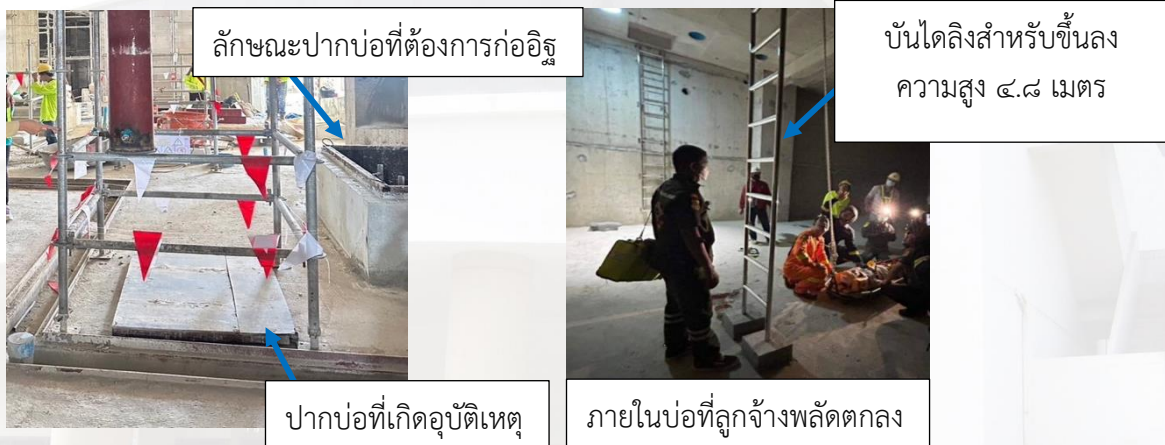
ภาพที่ ๑ บริเวณสถานที่เกิดเหตุที่ห้องเครื่องปั้มน้ำ ชั้น L และบริเวณภายในบ่อที่ลูกจ้างพลัดตกลงไป
