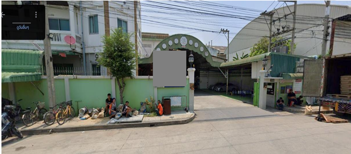
รูปภาพที่ ๑ สภาพอาคารและสิ่งแวดล้อมโดยรอบ
