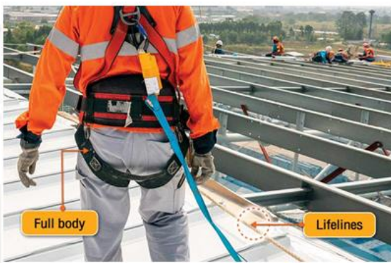
รูปที่ ๑๗ แสดงการใช้เข็มขัดนิรภัยและเชือกนิรภัยหรือสายช่วยชีวิตพร้อมจุดยึด
