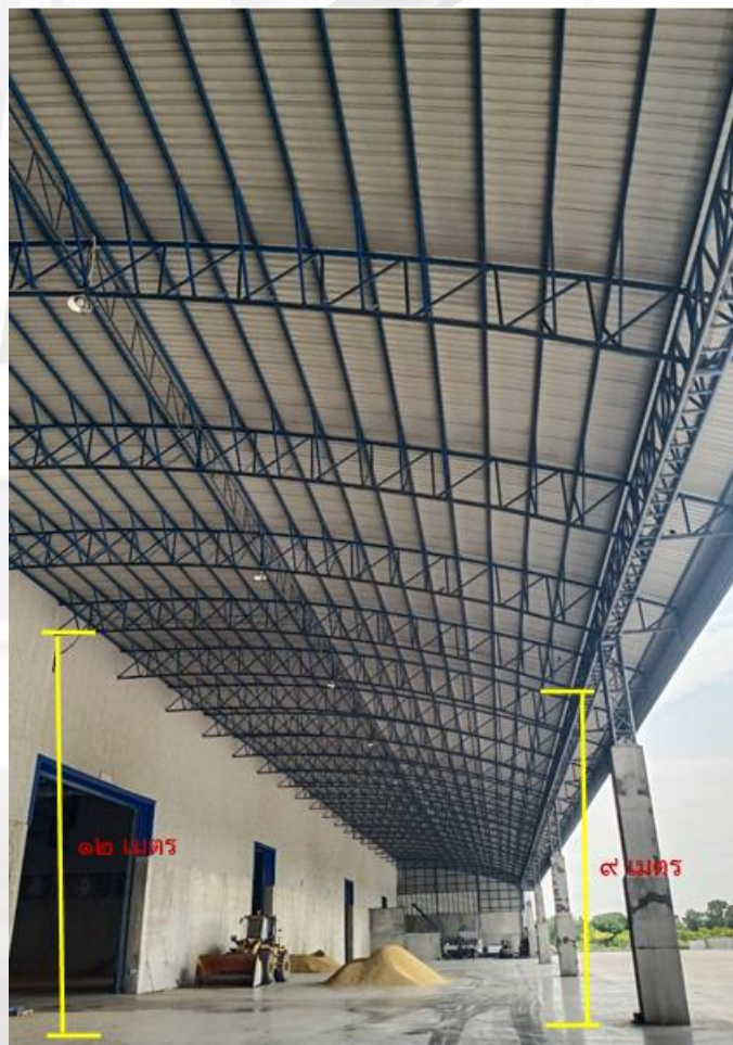
รูปที่ ๑ แสดงอาคารและบริเวณพื้นที่การทำงานเชื่อมเหล็กเสริมความแข็งแรงของโครงสร้างของหลังคาอาคาร
