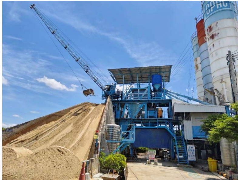
รูปที่ ๑ สถานที่ปฏิบัติงาน
