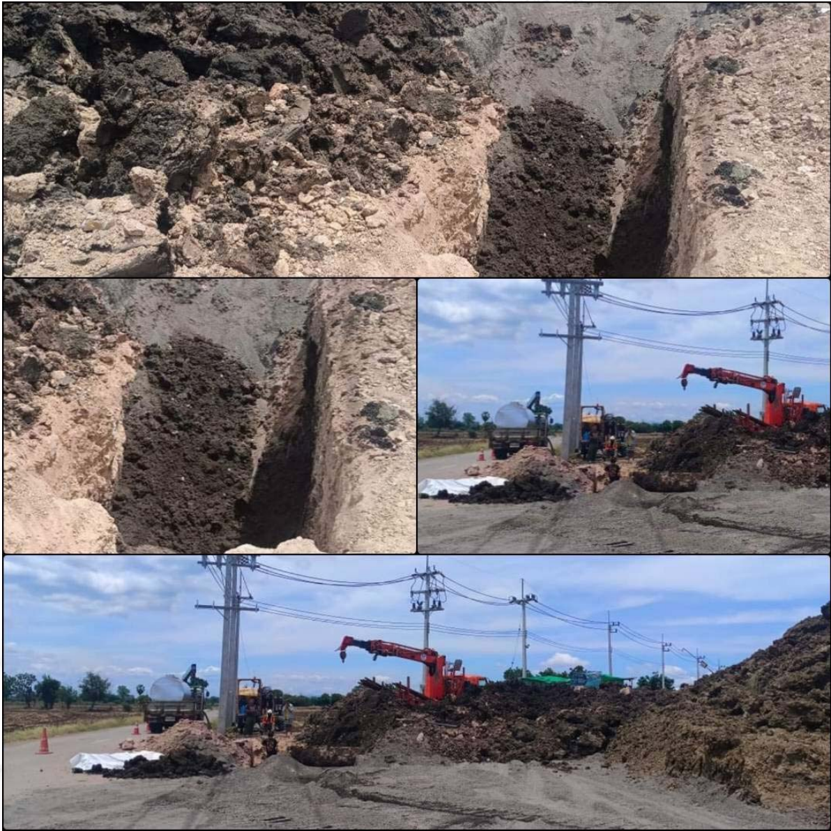
ภาพถ่ายสภาพพื้นที่การทำงานขณะทำการขุดเจาะ
