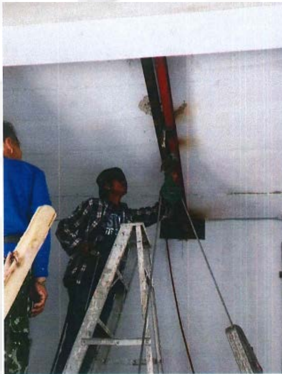
ภาพที่ ๒.๕.๓ ลักษณะการยืนเพื่อร้อยสายสลิงกับชุดรอกของลูกจ้างในขณะที่เกิดเหตุ
