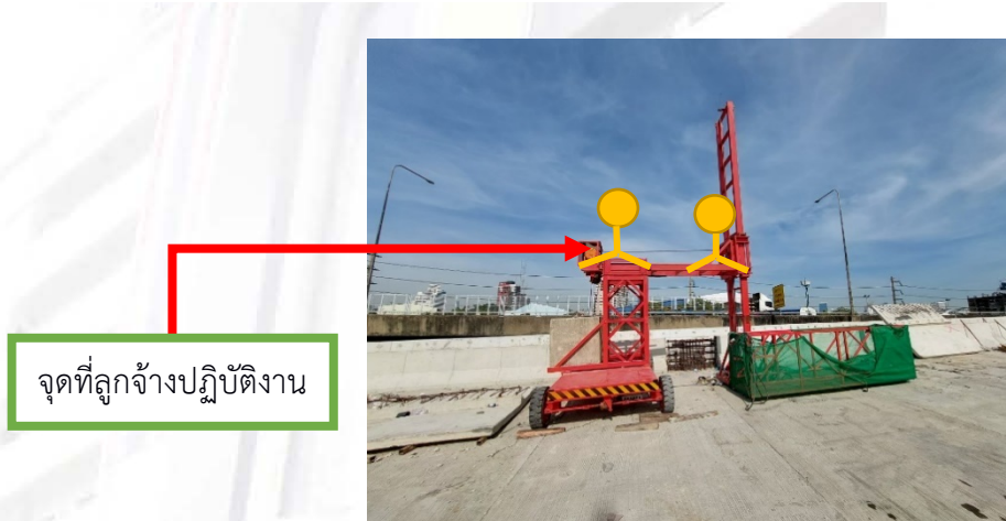
ภาพที่ ๒ กระเช้าแขวนที่เกิดอุบัติเหตุ
