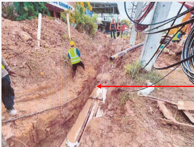
รูปที่ ๕ ทำแบบลาดเอียงในพื้นที่ปฏิบัติงาน
