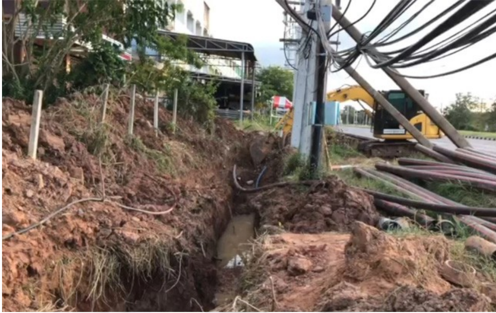
รูปที่ ๔ แนวร่องที่ขุดวางท่อร้อยสายไฟฟ้า
