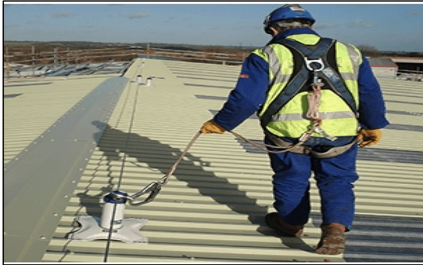
ภาพที่ ๓ แสดงสายช่วยชีวิต (life line) จุดยึดเกาะเชือกนิรภัย ทำจุดยึดเกาะ
