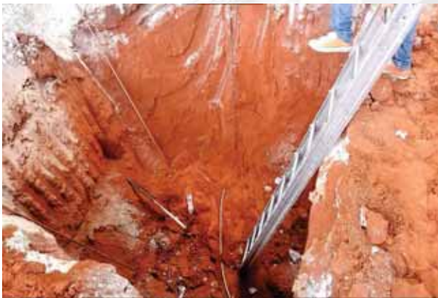
ภาพแสดง สภาพพื้นที่การทำงานก่อนวันเกิดเหตุ ขุดหลุม ความลึก ๓ เมตร ความยาว ๔ เมตร ความกว้าง ๒.๕ เมตร
