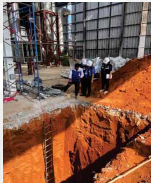
ภาพแสดง สภาพพื้นที่การทำงานในจุดเกิดเหตุ ขุดหลุมมีความลึก ๕ เมตร ความยาว ๘ เมตร ความกว้าง ๒ เมตร
