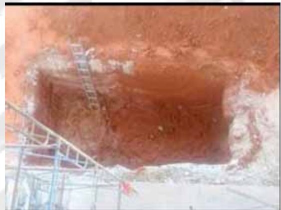
ภาพแสดง สภาพพื้นที่การทำงานก่อนวันเกิดเหตุ ขุดหลุม ความลึก ๓ เมตร ความยาว ๔ เมตร ความกว้าง ๒.๕ เมตร
