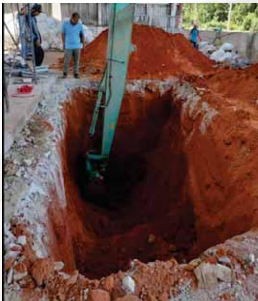
ภาพแสดง สภาพพื้นที่การทำงานในจุดเกิดเหตุ ขุดหลุมมีความลึก ๕ เมตร ความยาว ๘ เมตร ความกว้าง ๒ เมตร
