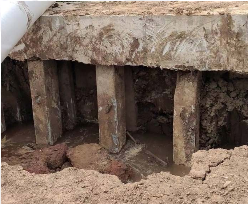
รูปที่ ๔ แสดงช่องระหว่างเสาเข็มที่มีดินอยู่ด้านใน
