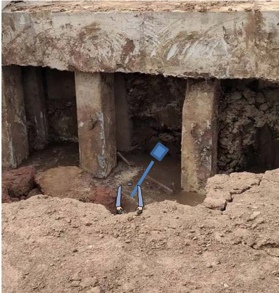
ลูกจ้ำงลงไปเซาะดินบริเวณช่องว่างระหว่างเสาเข็ม
