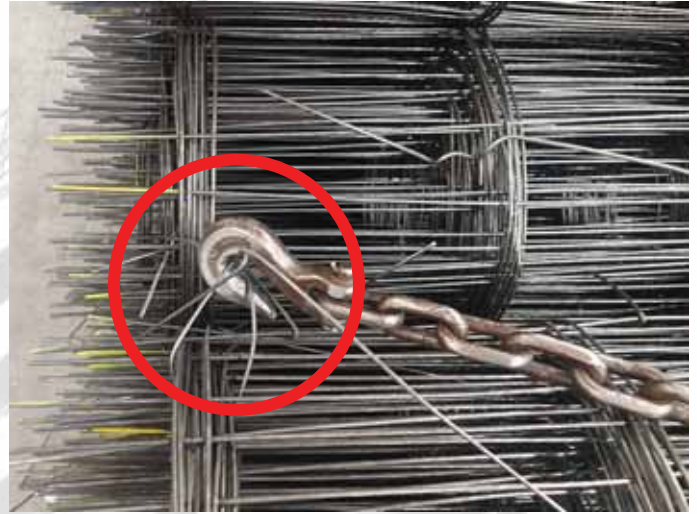
จุดที่คนงานใช้ตะขอเกี่ยวกับลวดที่มีตะแกรงไวร์เมฆ
