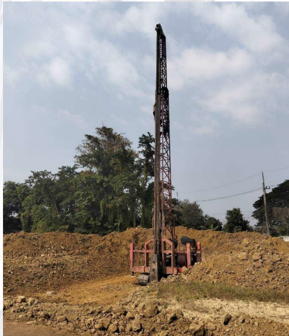
รูปภาพที่ ๒ เครื่องตอกเสาเข็มล้อยินตะขาบ
