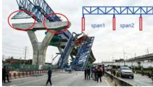
การก่อสร้างสะพาน (ทางยกระดับ) ระบบ Segmental box girder ด้วย Overhead Launching gantry
