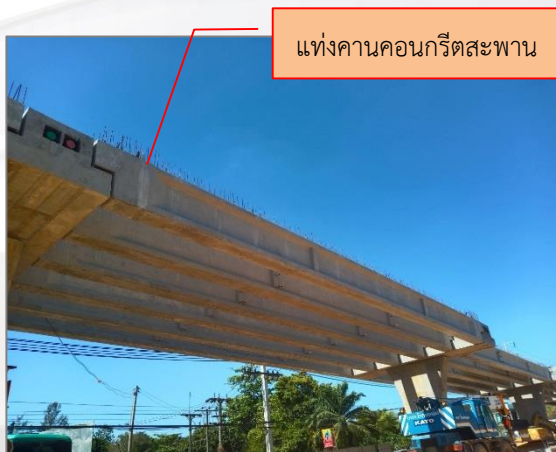
ภาพ : แท่งคานคอนกรีตสะพานที่ติดตั้งอยู่บนเสาสะพาน
