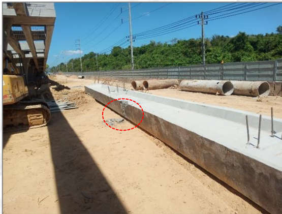
ภาพ : ตำแหน่งบนแท่งคานคอนกรีตสะพานที่สันนิษฐานว่าส่วนบนของอาร์ม (arm) รถแบ็คโฮชน
