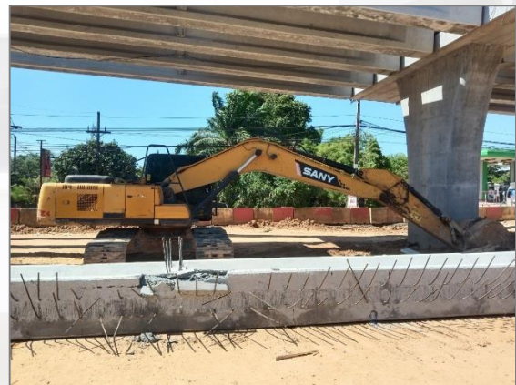
ภาพ : รถแบ็คโฮ (backhoe) ที่เกิดเหตุชนแท่งคานคอนกรีตสะพาน
