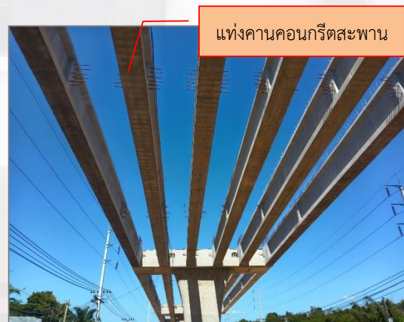
ภาพ : แท่งคานคอนกรีตสะพานที่ติดตั้งอยู่บนเสาสะพาน
