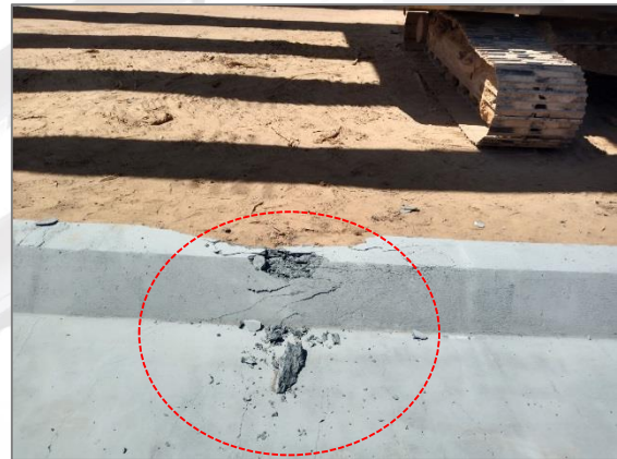
ภาพ : ตำแหน่งบนแท่งคานคอนกรีตสะพานที่สันนิษฐานว่าส่วนบนของอาร์ม (arm) รถแบ็คโฮชน
