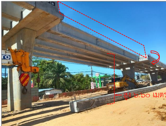
ภาพ : ตำแหน่งแท่งคานคอนกรีตสะพานที่ติดตั้งอยู่บนเสาสะพาน (ท้องคานอยู่สูงจากระดับพื้นดินประมาณ ๖.๖๐ เมตร)
