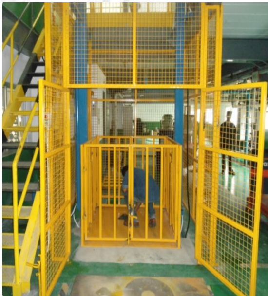
รูปที่ ๖ ตัวอย่างลิฟต์ขนส่งวัสดุที่มีคอกกั้น ประตูกั้น และเส้นแสดงเขตอันตราย (ที่มาของภาพ www.ลิฟท์ขนส่งของ.com , www.designliftengineering0989987544.com )
