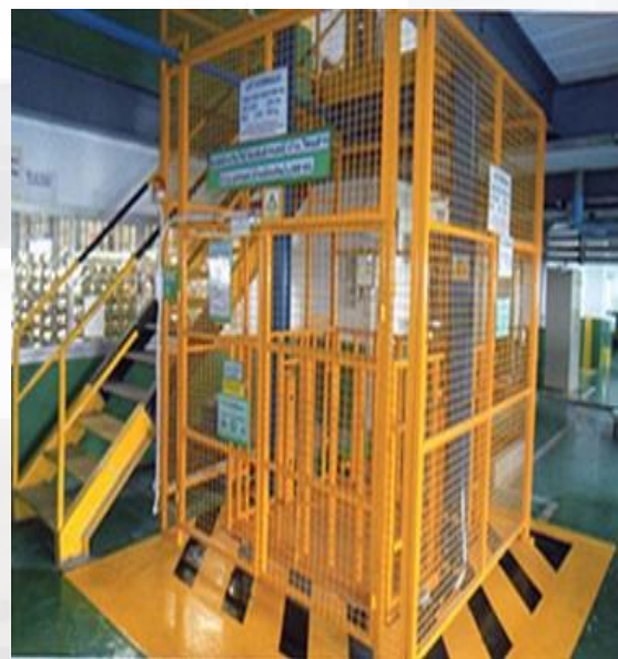
รูปที่ ๖ ตัวอย่างลิฟต์ขนส่งวัสดุที่มีคอกกั้น ประตูกั้น และเส้นแสดงเขตอันตราย (ที่มาของภาพ www.ลิฟท์ขนส่งของ.com , www.designliftengineering0989987544.com )
