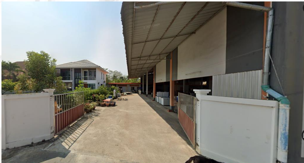
รูปภาพที่ ๑ สภาพอาคารและสิ่งแวดล้อมโดยรอบ
