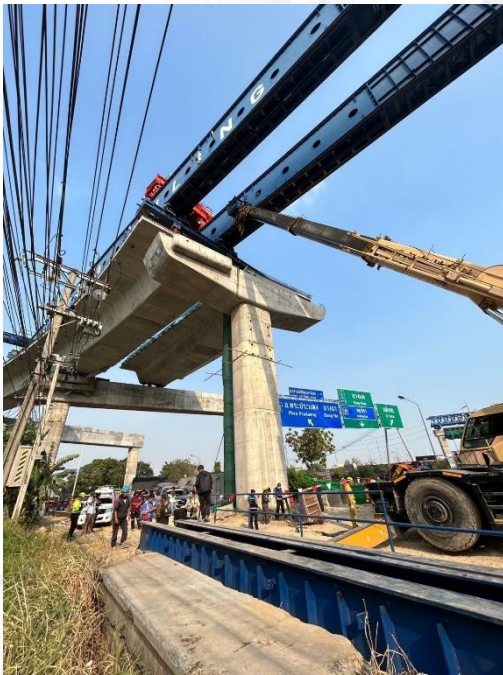
ภาพที่ ๑ แสดงการยึดบูมของปั้นจั่นในวันที่เกิดเหตุ
