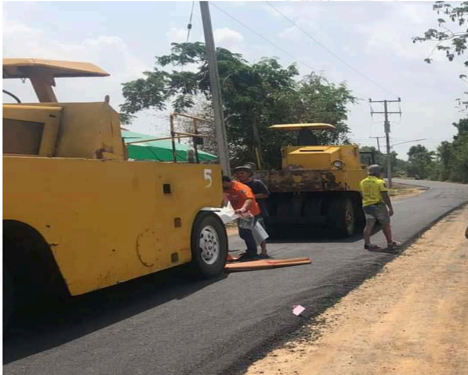
รูปที่ ๑ แสดงลักษณะรถบดถนนล้อยาง
