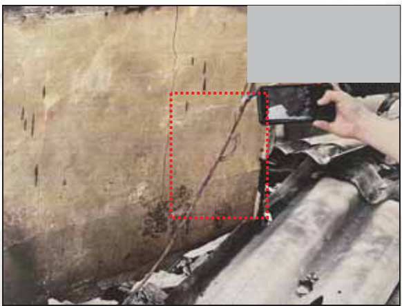
ภาพ : ความเสียหายของสายไฟฟ้า
