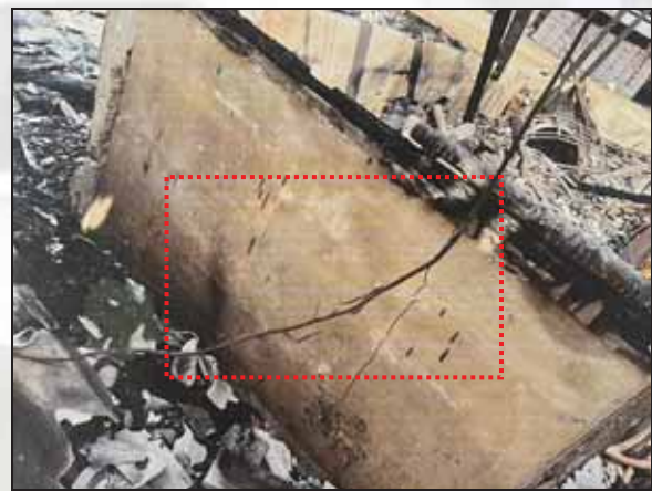
ภาพ : ความเสียหายของสายไฟฟ้า
