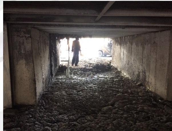
รูปภาพ บริเวณใต้เตาถลุงแร่ที่มีการรั่วไหลของโลหะดิบๆ
