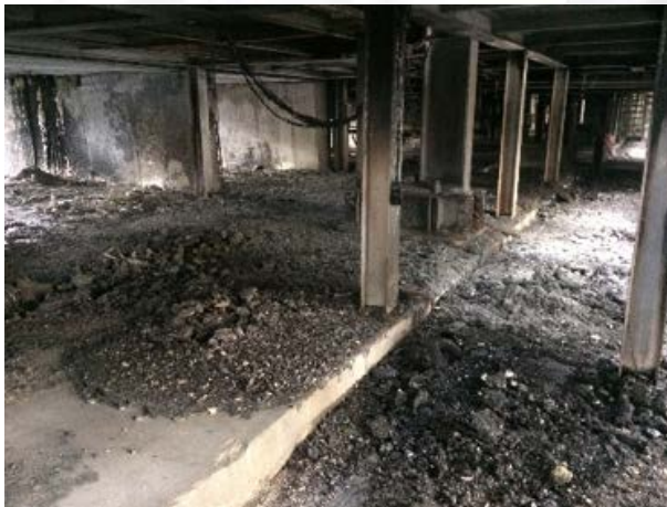
รูปภาพ บริเวณใต้เตาถลุงแร่ที่มีการรั่วไหลของโลหะดิบๆ
