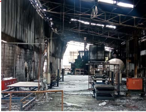
รูปที่ ๑๓ แสดงพื้นที่อาคารเก็บสินค้าสำเร็จรูปเพื่อรอจำหน่าย (Block Form Warehouse) ที่ถูกไฟไหม้
